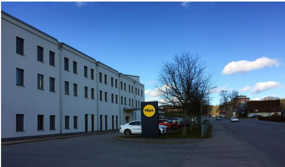
Figur 7: Kemistvägen och kontorsbyggnadens östra fasad. I bilden syns den södra infarten till fastigheten
